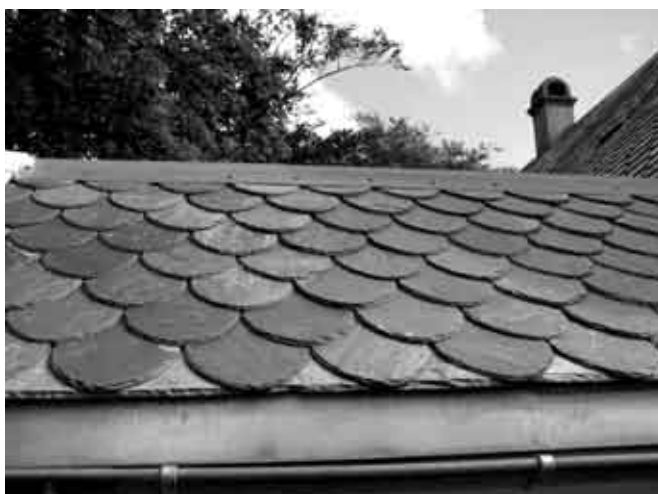
Fot. 3. Fragment dachu z łupka norweskiego
