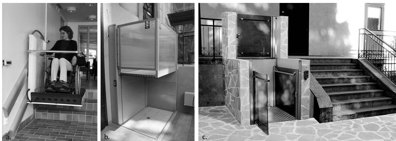
Ryc. 1. Proponowane rozwiązania: a. platforma schodowa o torze prostoliniowym, b, c. platformy pionowe (zdjęcia udostępniła firma Gold-Bud, www.gold-bud.pl )
